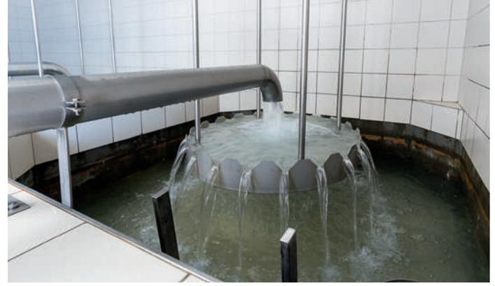
*Aufgrund des niederen pH-Wertes muss dem Wasser Kalk zugesetzt werden; dazu wird es zuerst in der Aufbereitungsanlage durch ein Kalkgestein gefiltert und schließlich in der Desinfektionsanlage aufbereitet*
